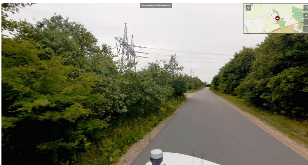
Figur 7-22 Højspændingsledninger- og master ved Station Idomlund set fra Idomlundvej. Transformatorstationen ligger til venstre for vejen. Blikket er rettet mod nordvest. Kilde: COWI Gadefoto.
