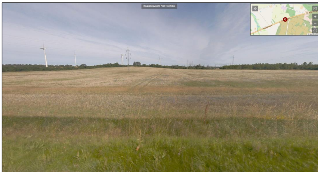
Figur 10-4 Station Idomlund set fra Ringkøbingvej syd for anlægget. Kilde: COWI Gadefoto.
